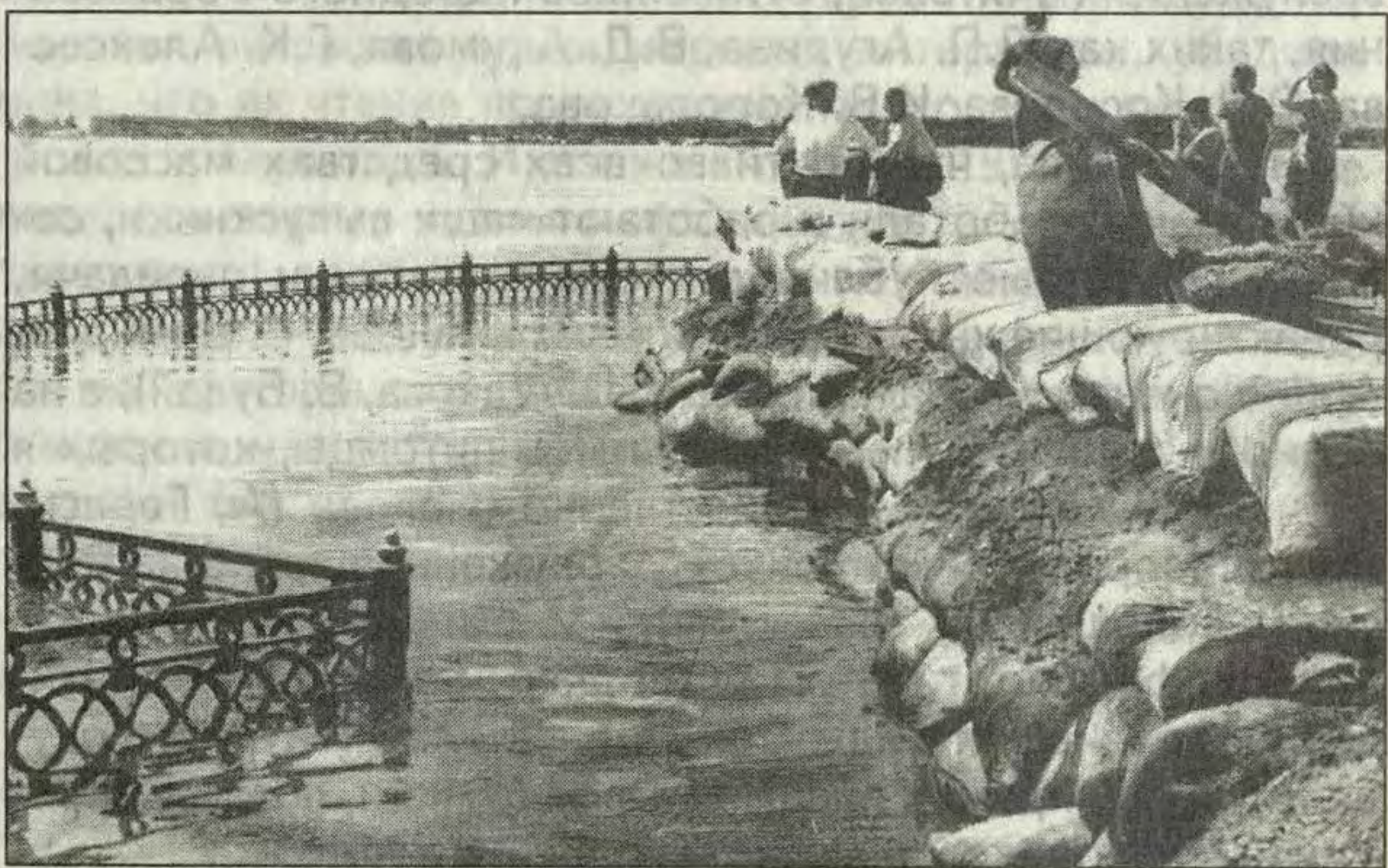
Строительство дамбы на набережной реки Амур во время новодония. г. Благовещенск. 25.07.1958 г.
