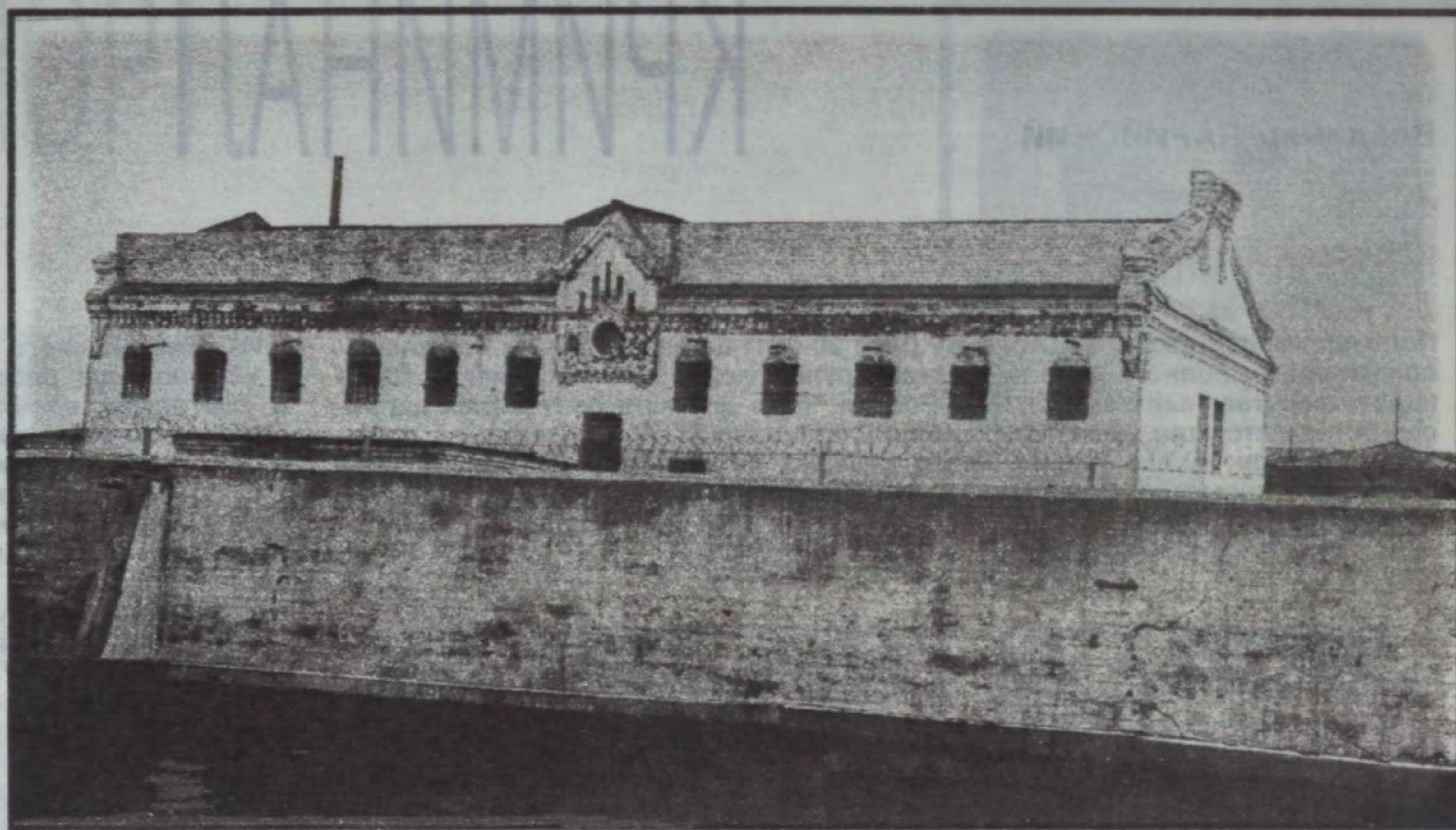
Красный корпус иркутской тюрьмы.
