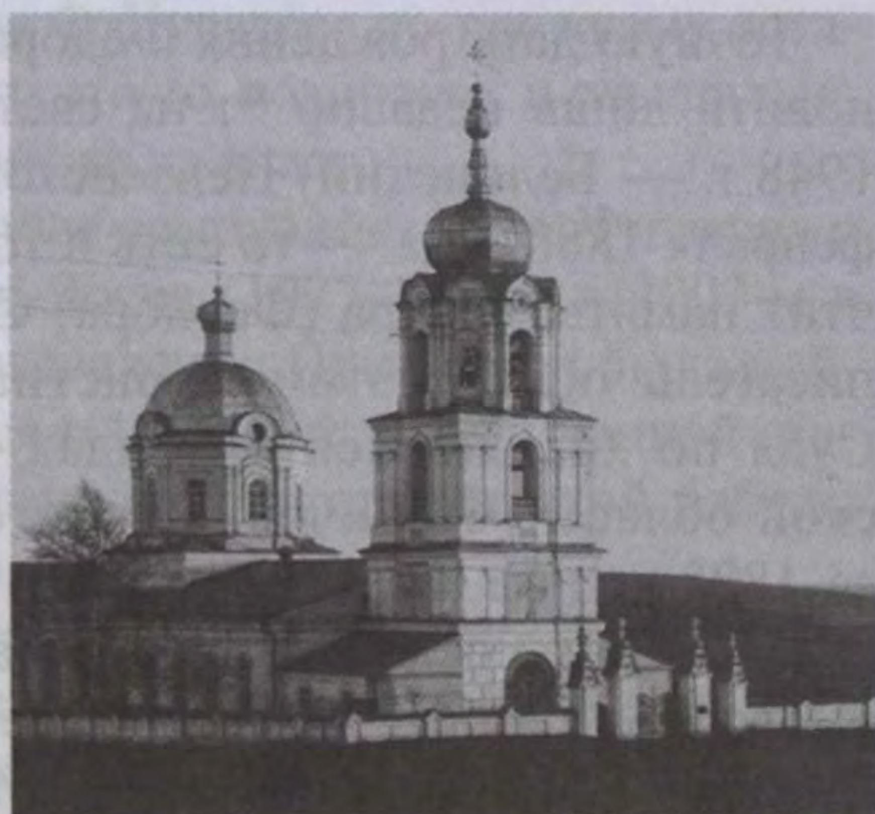
Никольская церковь в Чембаре
