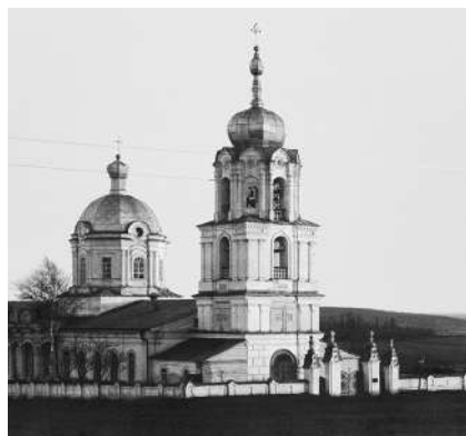
Никольская церковь в Чембаре
